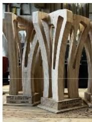
Structure réciproque pentagonale en châtaignier, avec suggestion d'assemblage à queue d'aronde.
